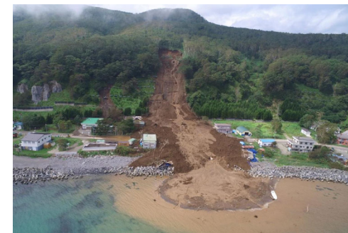
豪雨による緩斜面災害で集落が孤立
