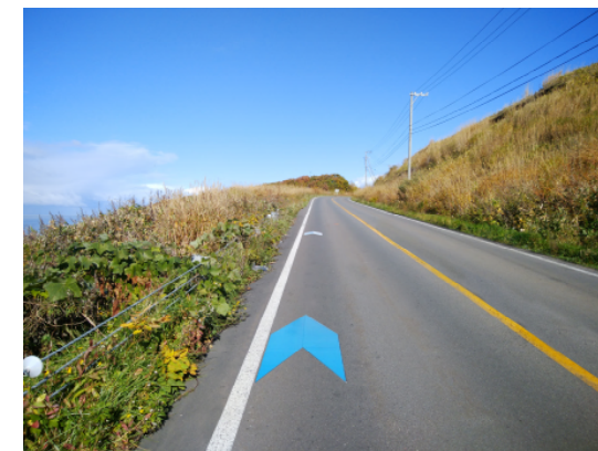
矢羽根型路面表示設置（急カーブ手前）
