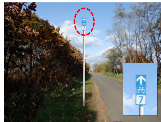
案内看板設置（単独柱方式）
