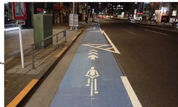
国道246号（青山地区）
