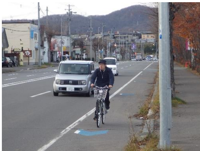
R1施工：単路部
