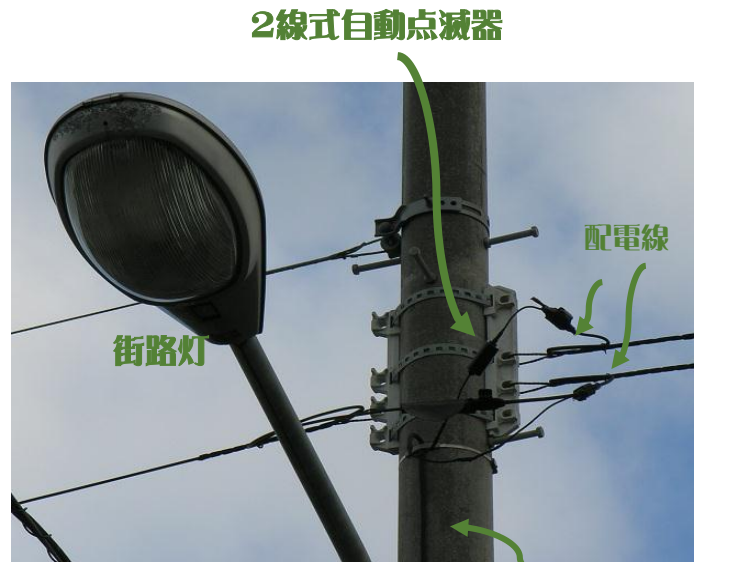
街路灯取付状況
