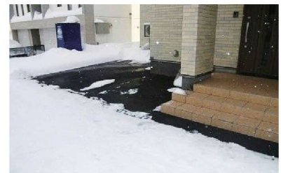
蓄熱利用のロードヒーティング
