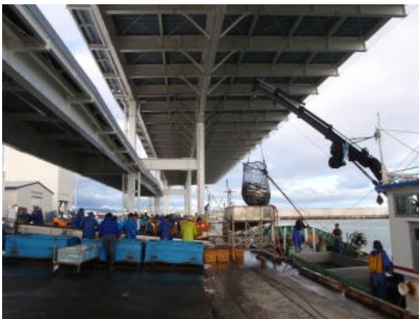
【衛生管理対策としての屋根付岸壁整備】
