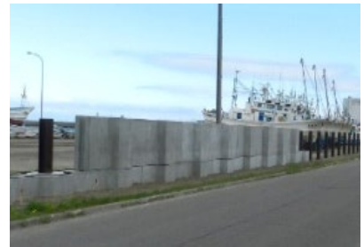
施設整備状況
