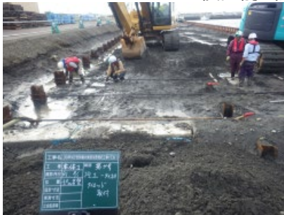
復旧工事の実施（タイ材取付 及び コンクリート舗装）
