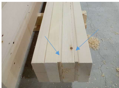
■パッキン材使用状況
