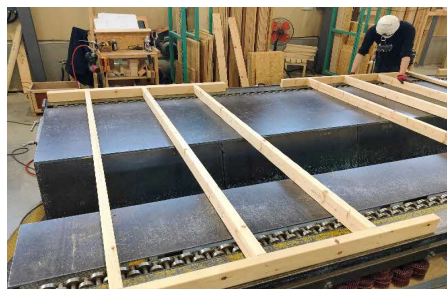
■パネル組み上げ風景②
