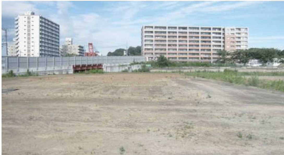
粉塵飛散防止材の施工した地面
