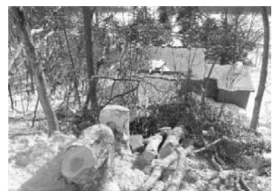
伐採終了後の状況
