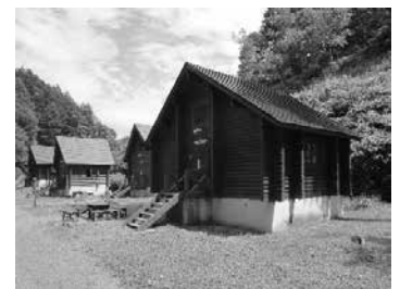
長寿命化対策を実施した施設
