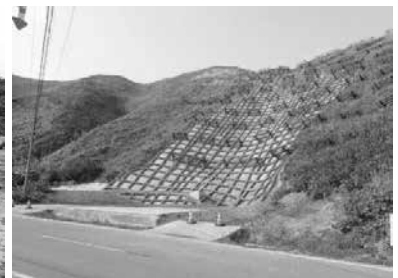
被害箇所の復旧状況(礼文町)
