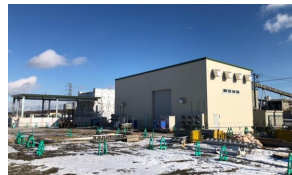
水素製造装置建屋 外観
