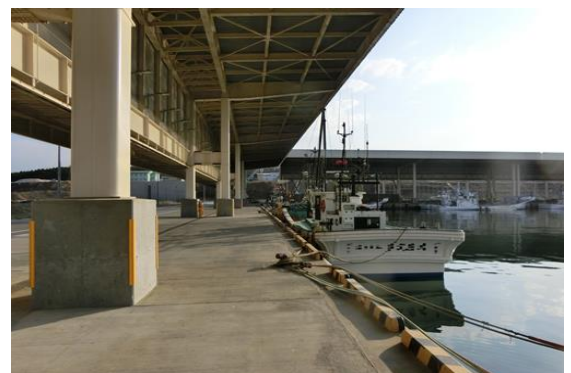
【屋根付き岸壁を整備した漁港（常呂漁港）】
