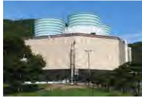
北海道電力(株) 森地熱発電所
