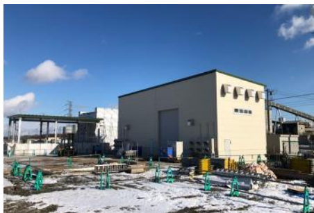
水素製造装置建屋 外観
