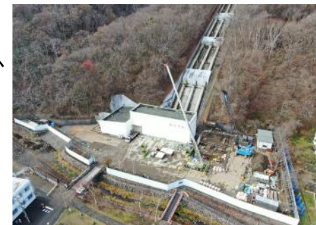
藻岩発電所リプレース工事の様子
