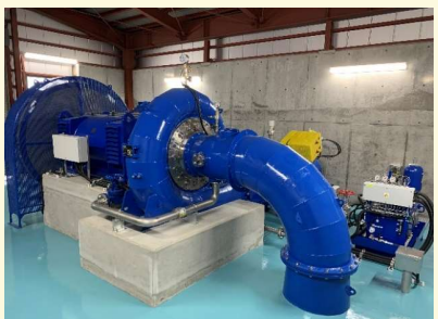
MAVEL社のフランシス水車を導入した 安房谷水力発電所（岐阜県/657kW）
