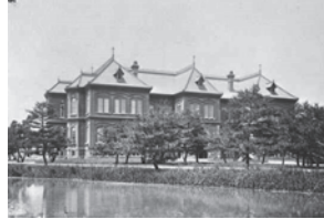
明治44年火災復旧工事
