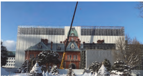
素屋根と転写シート
