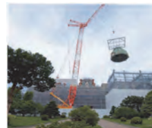
八角塔屋根の移設の様子
