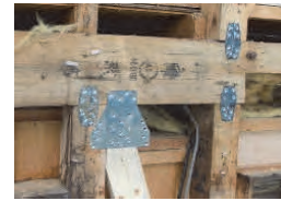
補強金物の設置
