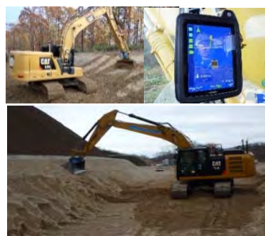
ICT建設機械による施工
