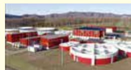
バイオガスプラント
