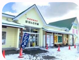
[写真] 施設外観
