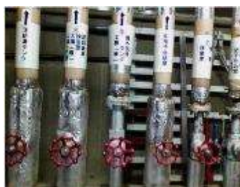
写真-IV.2.3 他工場事例
