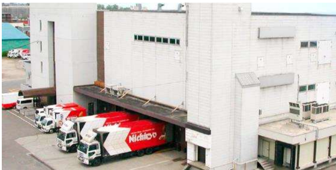
写真-IV.2.1 施設外観
