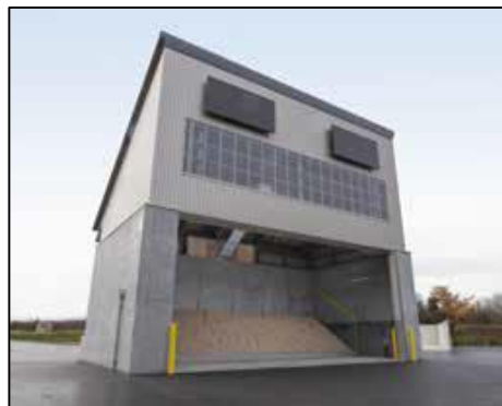
▲太陽光を活用した木質チップ乾燥設備
