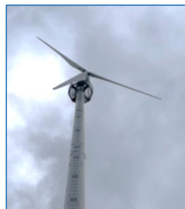
▲自社の風力発電所
