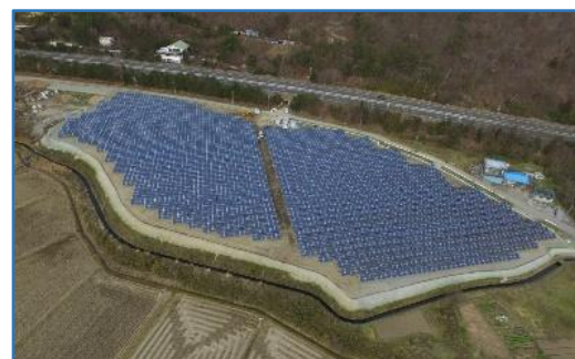
▲設計・施工した太陽光発電所
