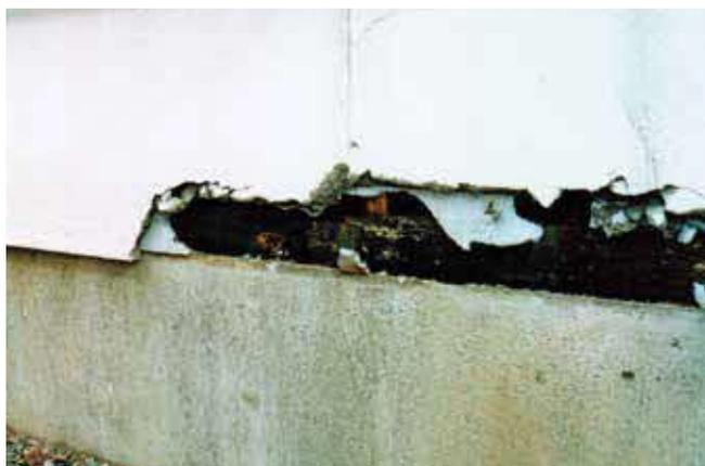
土台の腐食。夏場の床下換気により回避できます。
