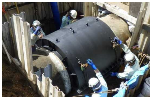
H30胆振東部地震 漏水復旧作業
