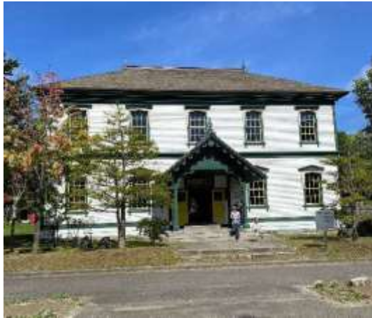
旧開拓使工業局庁舎（国指定重要文化財）
