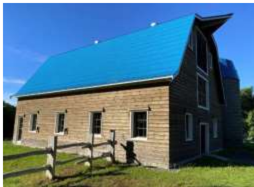
柿葺きから重ね葺きで改修した事例（旧小川家酪農畜舎）
