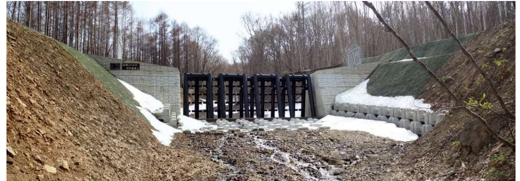
■稲積1の沢川 透過型砂防堰堤(札幌市)
