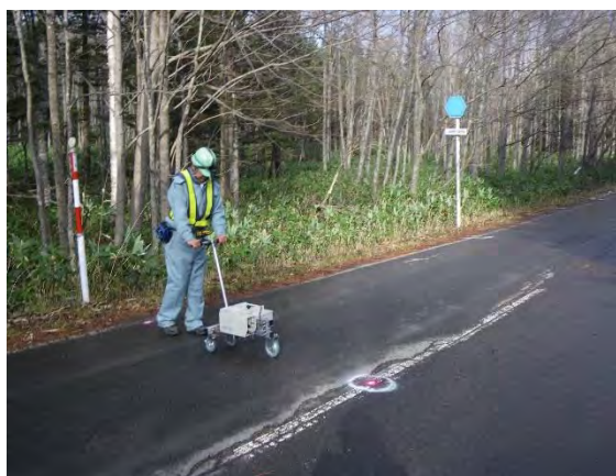
機器によるわだち掘れの点検例（小型プロファイラ）
