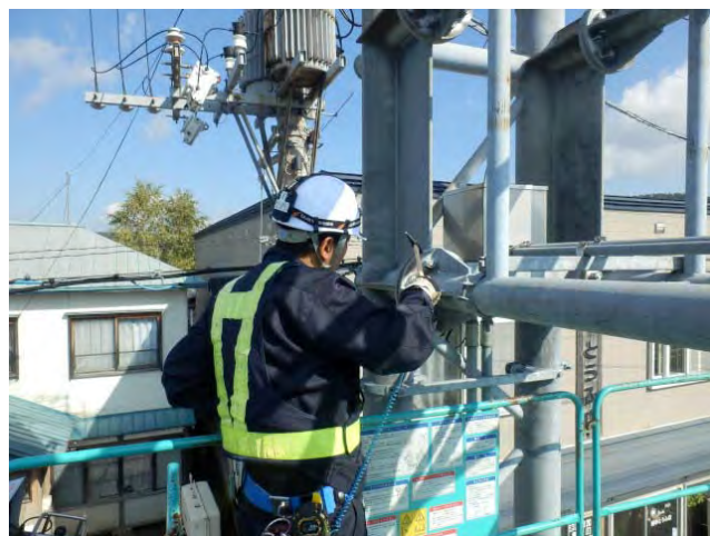
ボルト打音検査作業状況の例
