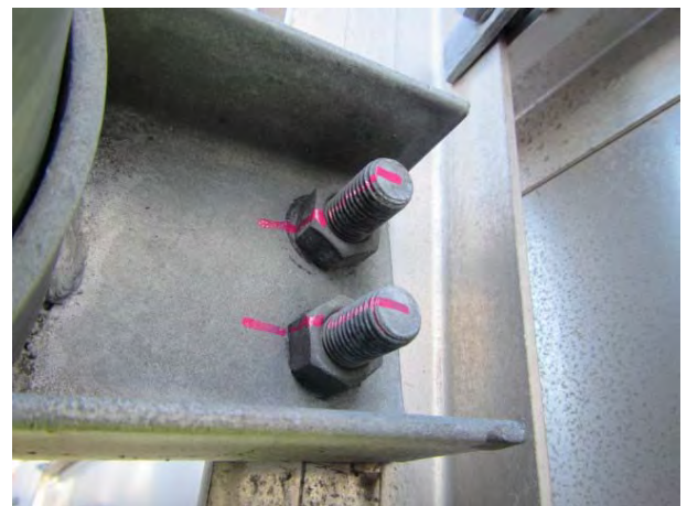
ボルトの再締付例
