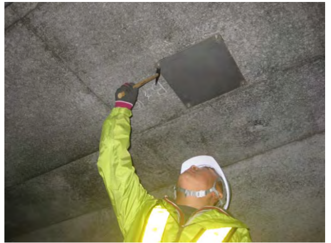
大型カルバートの打音点検作業状況の例
