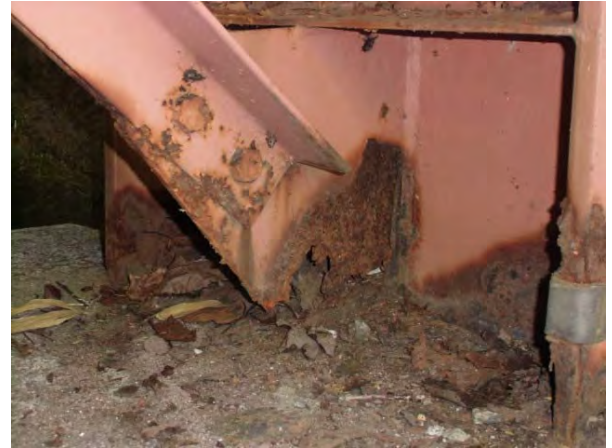
鋼製部材の亀裂例
