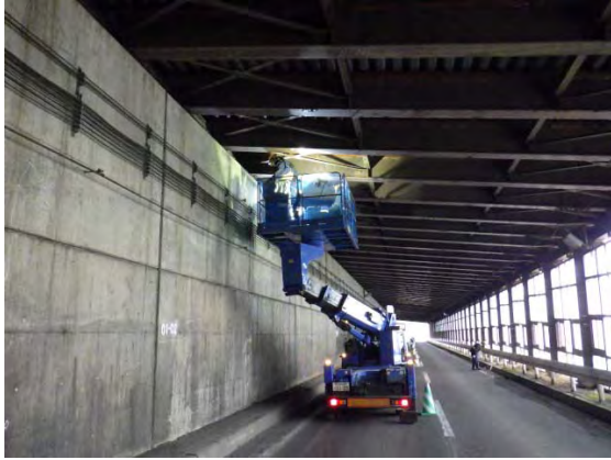
シェットの近接目視作業状況の例
