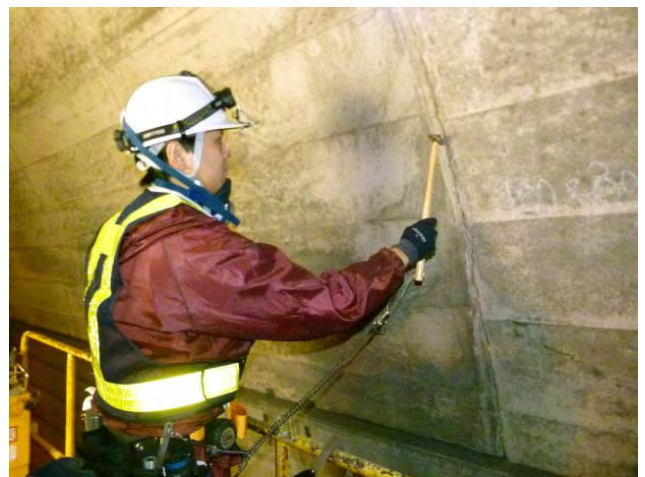
打音検査作業状況の例
