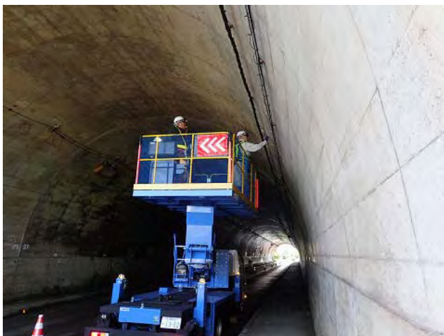
近接目視作業状況の例
