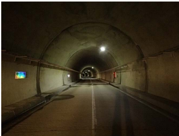
写 5-2 修繕工事例 (面導水設置)
