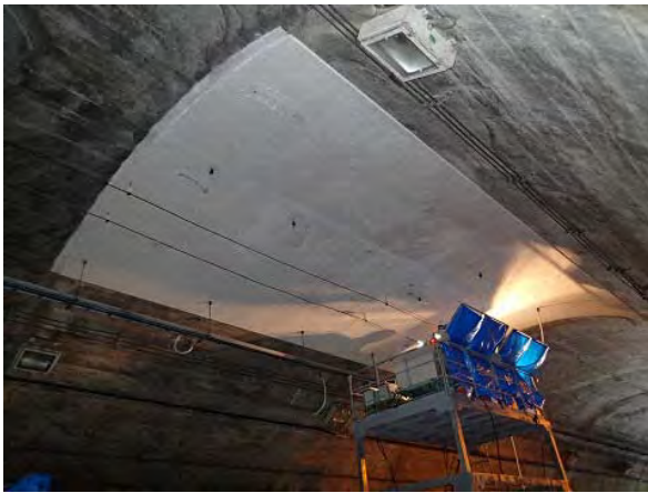
写 5-1 修繕工事例 (裏込め注入)
