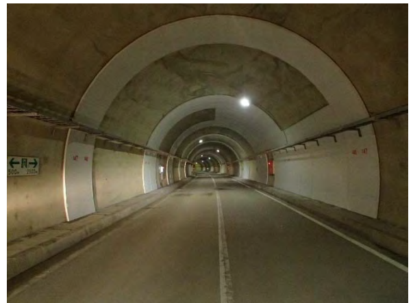
写 5-2 修繕工事例 (面導水設置)
