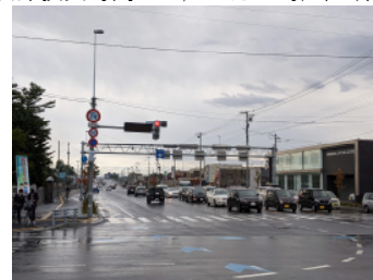
整備後状況写真 (交差点部で渋滞が解消された状況)
