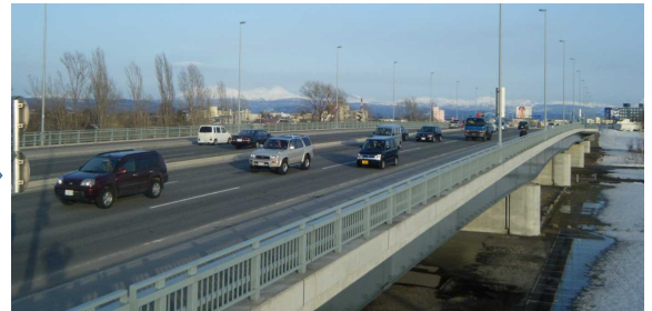
整備後状況写真
