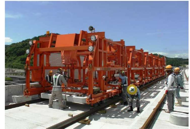
スラブ運搬・敷設状況
