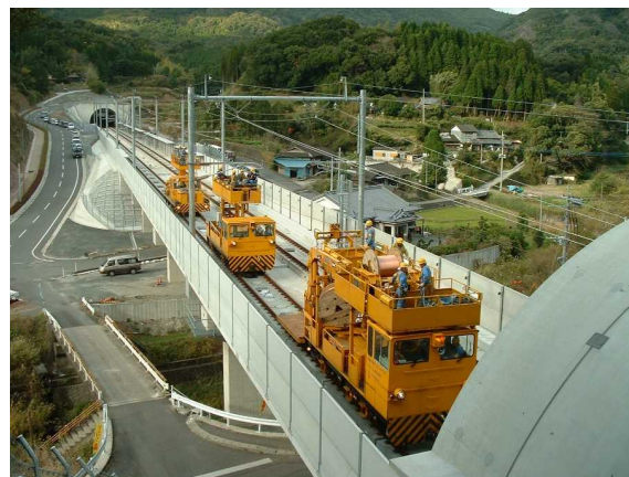
③電車線の延線
