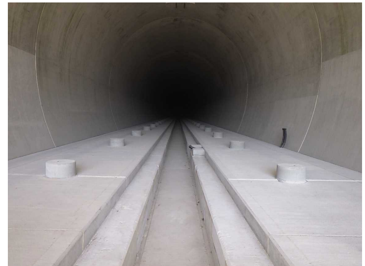
路盤・突起コンクリート 完成状況
