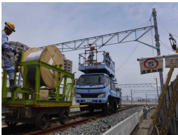
②き電線の延線
