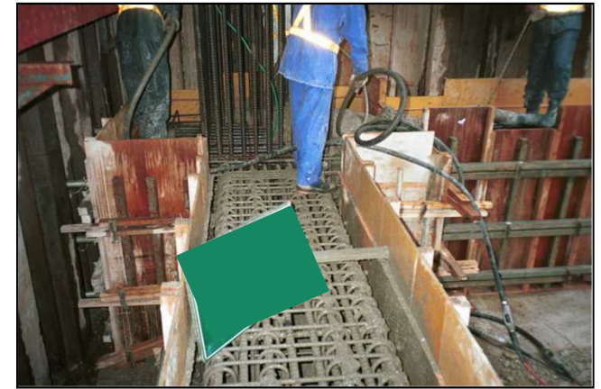
基礎コンクリート打設状況
