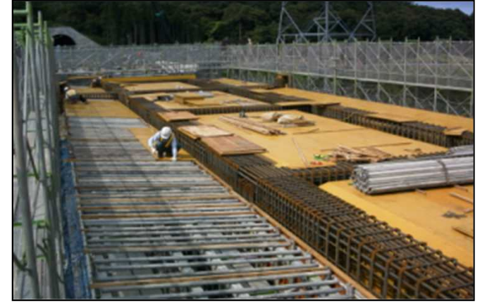
高架橋スラブ型枠・鉄筋組立状況
