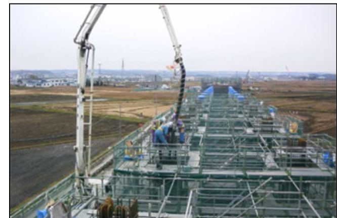
柱コンクリート打設状況
