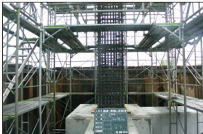
柱鉄筋組立状況
