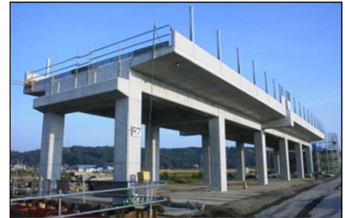
高架橋本体完成状況
