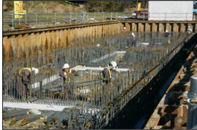
基礎鉄筋組立状況
