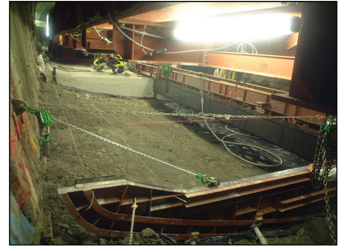
掘削作業完了状況
