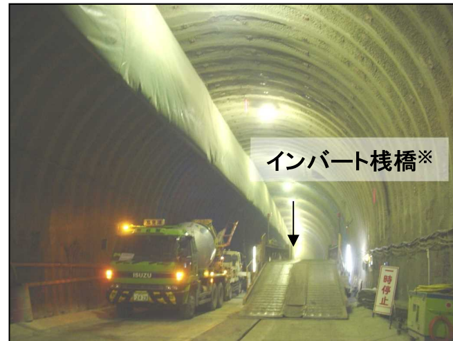
コンクリートの打設状況
