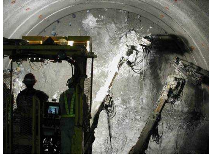
爆薬を装薬するため、地山に穴をあける作業
