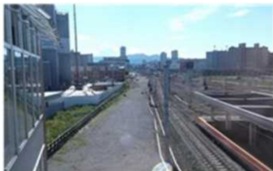
苗穂駅付近から札幌駅方面を望む (狭隘な箇所)
