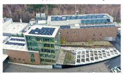
③ダブルスキン外装設備 /建物断熱負荷抑制 外壁にガラスのダブルスキンを 採用し、外壁からの熱負荷を抑制。
