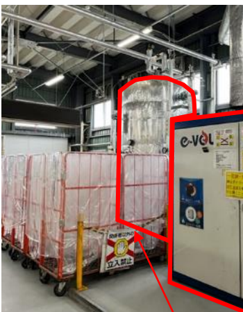
①ペレットを専用 ボイラーで熱源に
