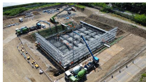
▲札幌市水道局物件納入時の様子
