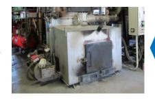
廃棄が必要な菌床や間伐 残材をバイオマスボイ ラーの燃料として使用し、 菌床栽培の温度を管理
