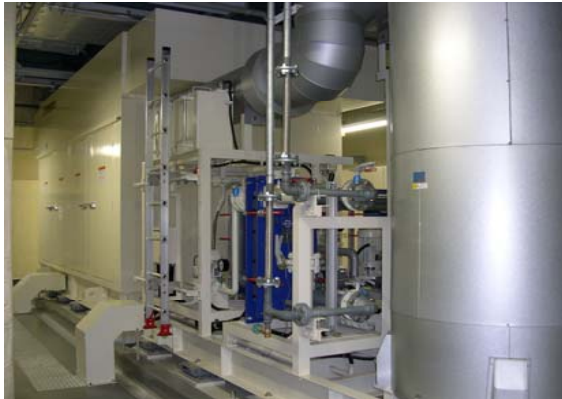
装置全体 奥の箱がガスエンジン発電機、手前に熱回収装置が見えます。 同じものが3台あります。
