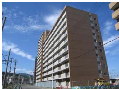
H20 優秀対象現場 道営住宅新築工事（築港団地）
