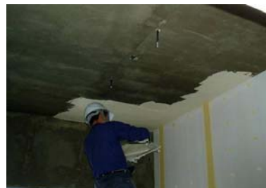
登別明日中等教育学校(寄宿舎)の天井に施工
