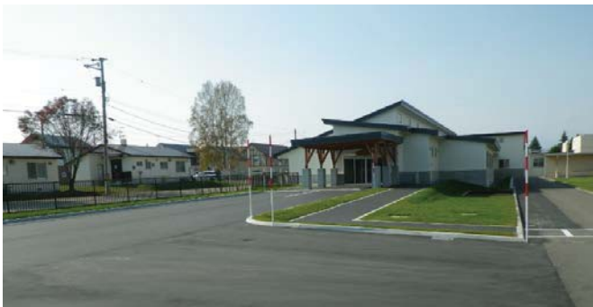
【学校施設（車両用通路）】
