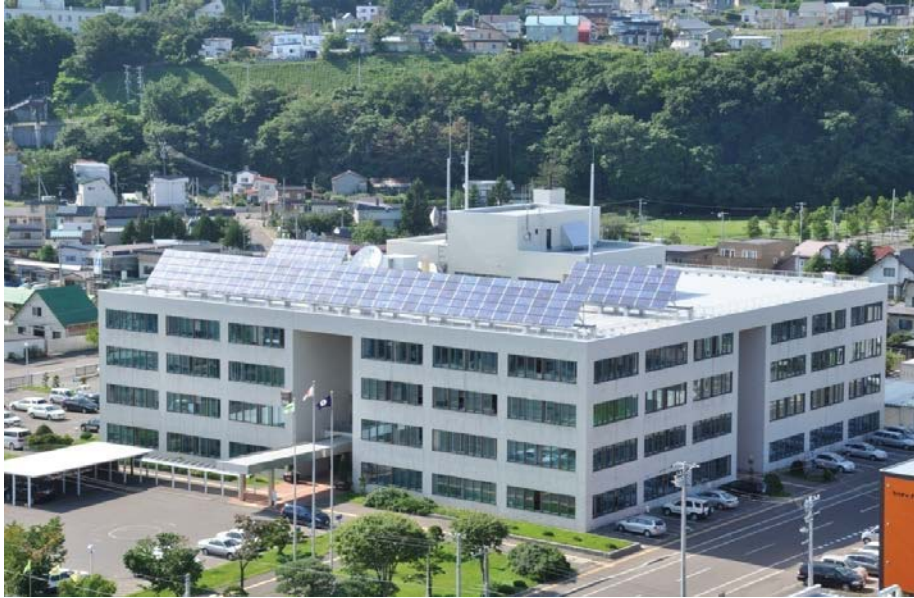
● 北海道オホーツク総合振興局庁舎 定格出力 40KW
