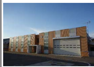
北海道岩見沢農業高等学校畜産実習棟
