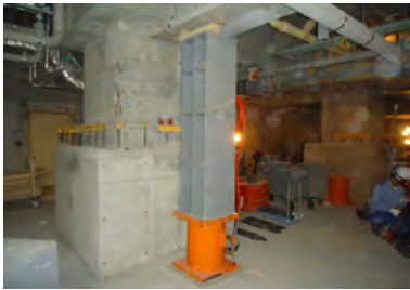
免震柱補強完了・仮受支柱設置
