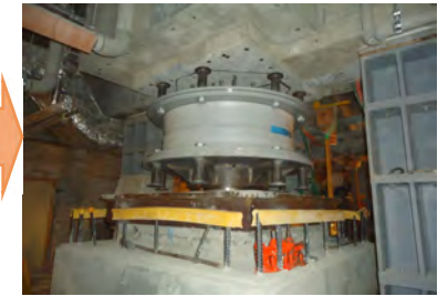
免震装置設置
