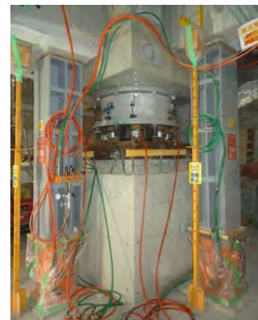
免震装置プレロード工法 (ジャッキによるプレロード導入)
