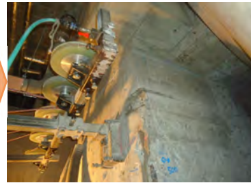
柱ワイヤーソー切断
