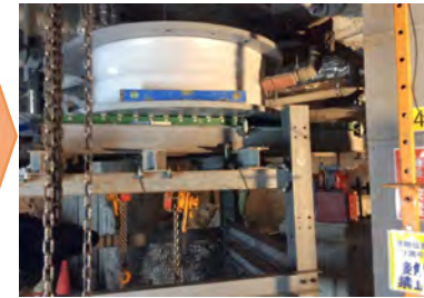
免震装置引込み
