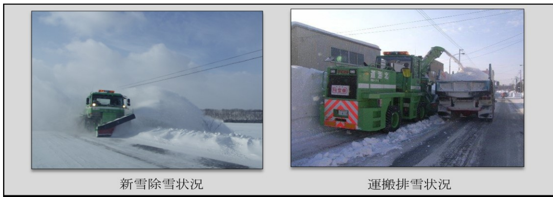
図 14 道道の除排雪状況
