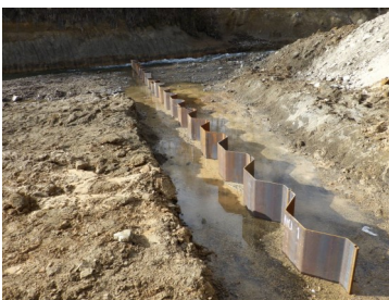
③ 帯工（矢板打ち込み完了）
